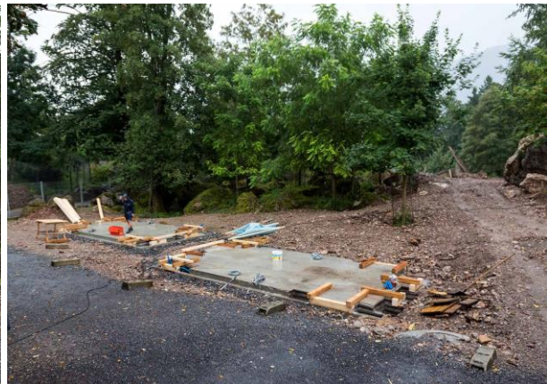
Vorbereitung des Turmfundaments für die Holzelemente
