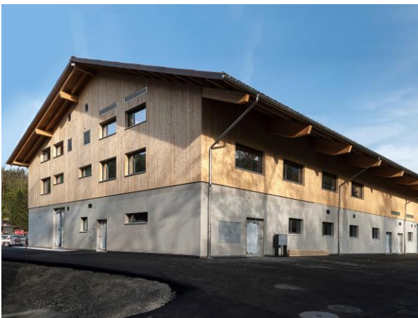
Das neue «Multifunktionale Gebäude», genannt «MUFU»
