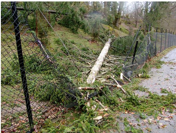
Durch umstürzende Bäume wurde auch der Aussenzaun beschädigt
