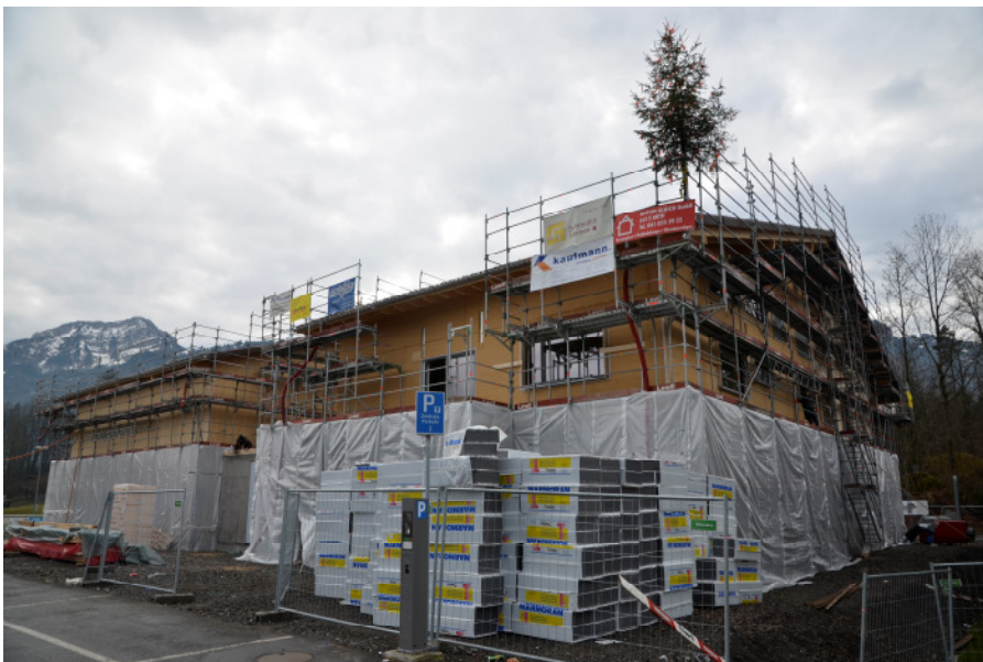
Aufrichte beim multifunktionalen Gebäude im Natur- und Tierpark Goldau
