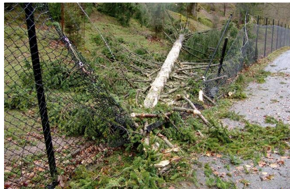
Der Sturm Burglind richtete Schaden in der Grössenordnung von CHF 100 000 an
