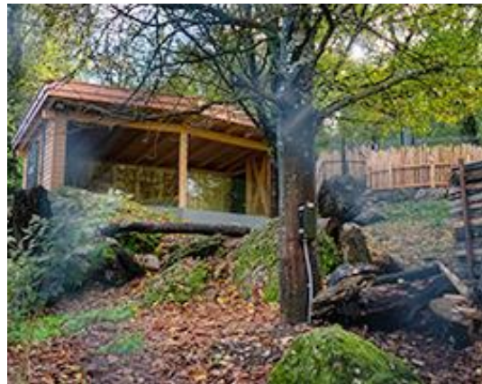
Die neue Anlage ist doppelt so gross wie die ehemalige.
