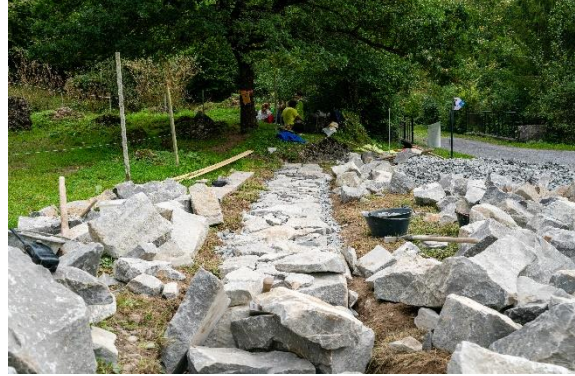
Nach einer Woche Arbeit steht das Fundament der Trockensteinmauer.
