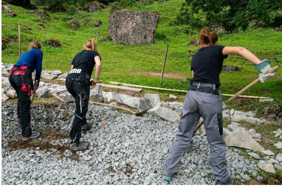
Jugendliche der Fachmittelschule Luzern bei der Arbeit an der Trockensteinmauer.
