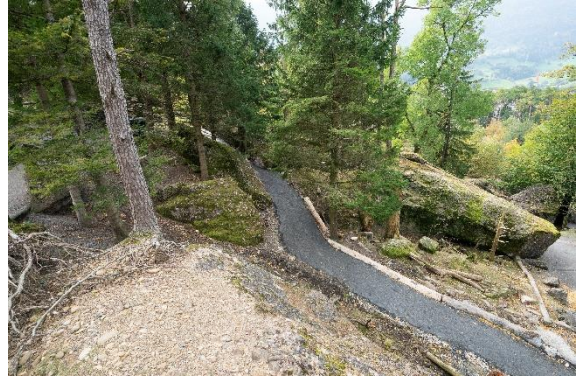
Wo einst die Kolkraben waren, führt ein provisorischer Weg um die Baustelle herum.
