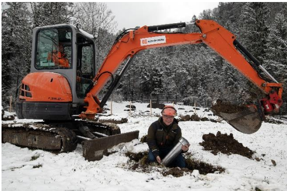
Joe Michel, Leiter Bau & Infrastruktur, mit der Zeitkapsel, die auf dem Areal Grosswiler vergraben wird.
