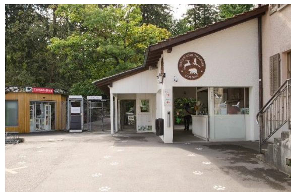
Der Eingang des Tierparks wurde in den 60-er Jahren erbaut und hat dringenden Erneuerungsbedarf.
