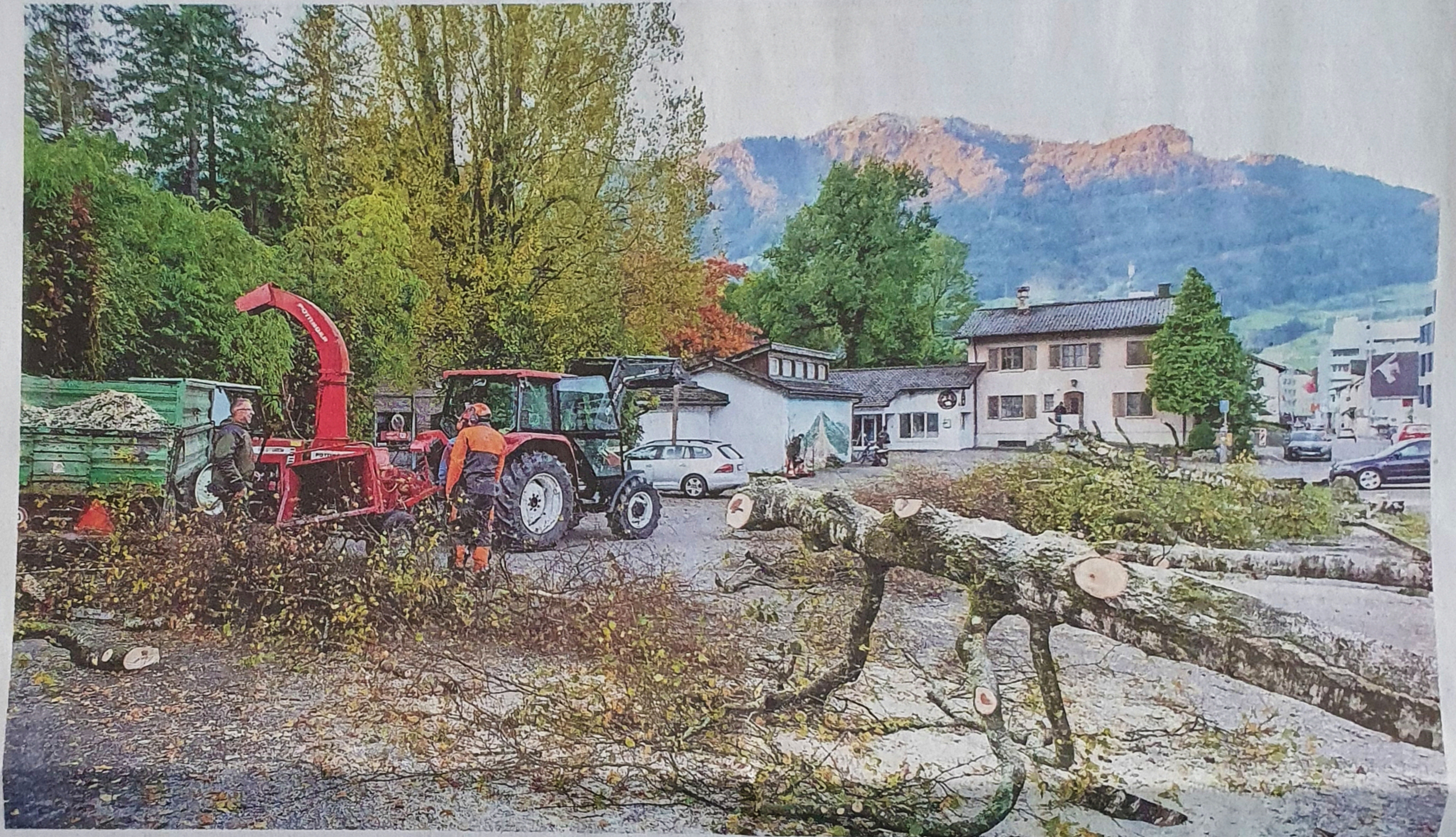
Noch vor dem gestrigen Besucher-Grossansturm wurden die Bäume vor dem Eingangsbereich des Tierparks gefällt. Hier entsteht der Neubau des Tierparks Goldau. Der Tierpark baut in den nächsten zweieinhalb Jahren einen völlig neuen Eingangsbereich.
