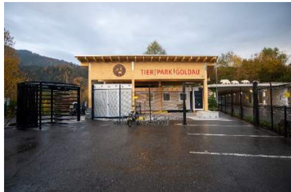
Anfangs Woche wurde der provisorische Eingang an der Steinerbergstrasse 47 in Betrieb genommen.
