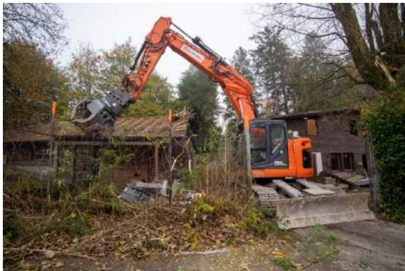
Heute fahren die Bagger in Goldau auf.
