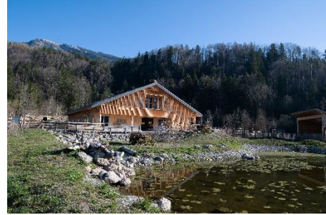
Im Zentrum der neuen Anlage steht der Grosswiler Hof, in welchem Nutztiere ihr Zuhause gefunden haben.
